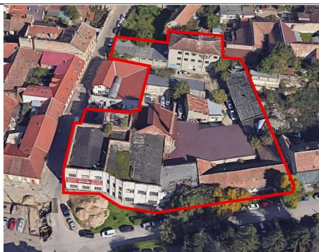
Figură 10 Imagine aeriană a incintei fostei Fabrici Crinul, incluzând fosta moară Hammes și Singer și a fostului depou de tramvaie cu cai
