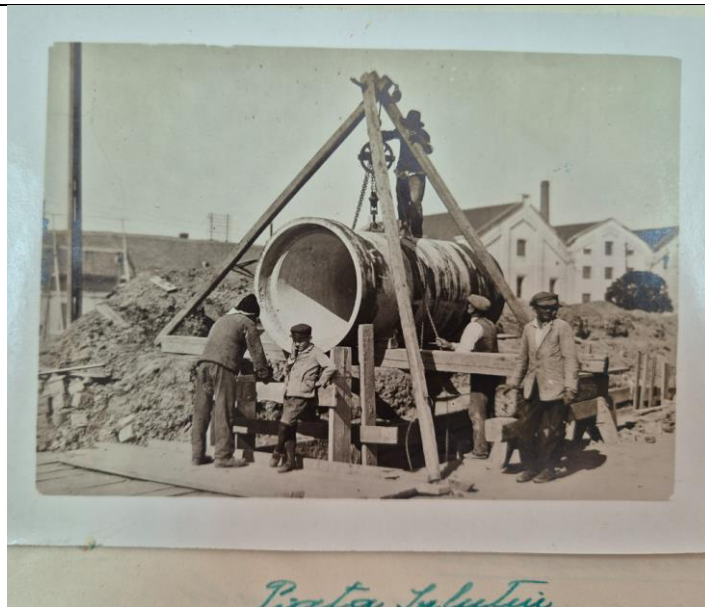
Anul 1930, Imagine din perioada montării țevilor de canalizare, Piața Suluțiu 126
