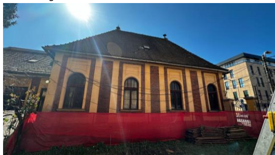
Fațadă laterală volum la stradă a Casei de Rugăciune Sursă: Gabriela Domokos – Pașcu
