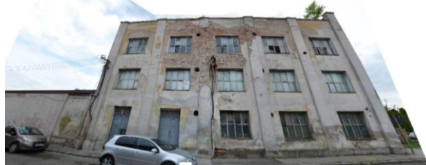
Figura 13 Fațada din lungul străzii Anton Pann
