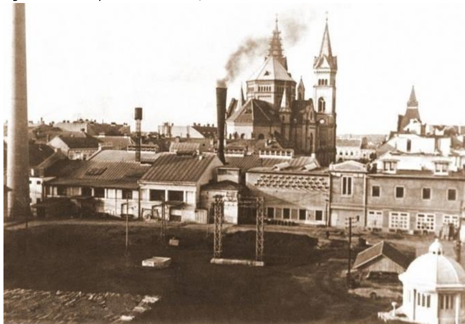
Figură 8 Vedere de ansamblu a uzinei electrice, 1930. 82
