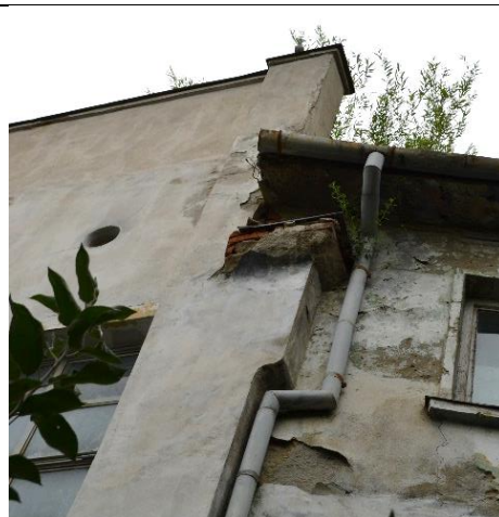
Figura 15 Profilatură a cornișei pilastrului lateral menținută din configurația anterioară – corp secundar estic
