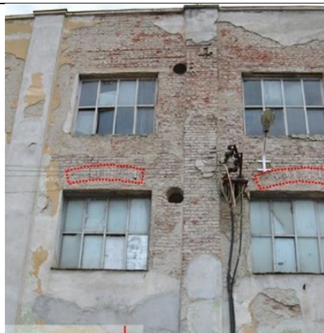
Figura 14 Detaliu al unor arcade de cărămidă zidite specifice sistemelor istorice de zidire la partea superioară a ferestrelor,
