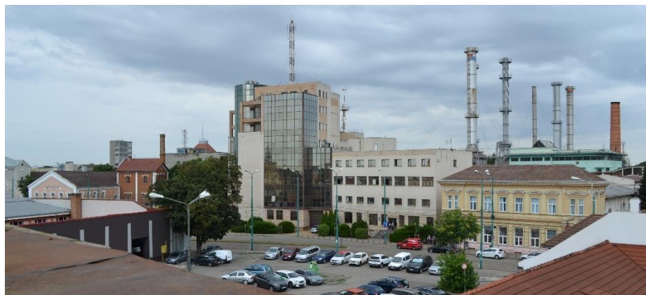
Figură 8 Vedere din incinta Crinul, panoramă asupra Fabricii de Bere, PPC și fosta berărie Ursul Negru 68
