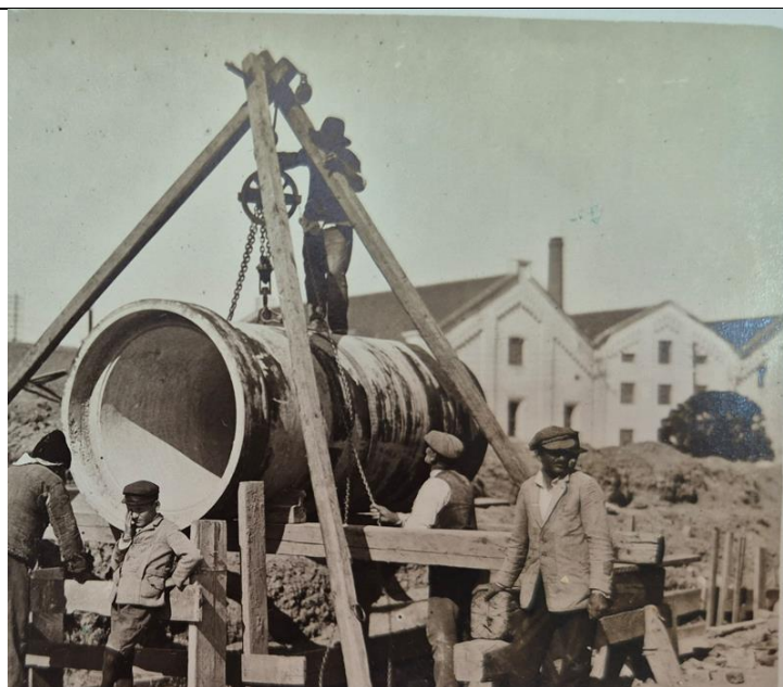
Figură 7 Imagine cu montajul canalului de aerisire al Uzinei electrice, anul 1929. În fundal fosta moară, cu trei corpuri corelate între ele, unul construit central peste fostul canal.
