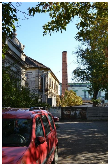
Figură 11 Vedere în lungul fostului splai Kunz, integrat în interiorul actualei incinte PPC/Colterm, 2025 71
